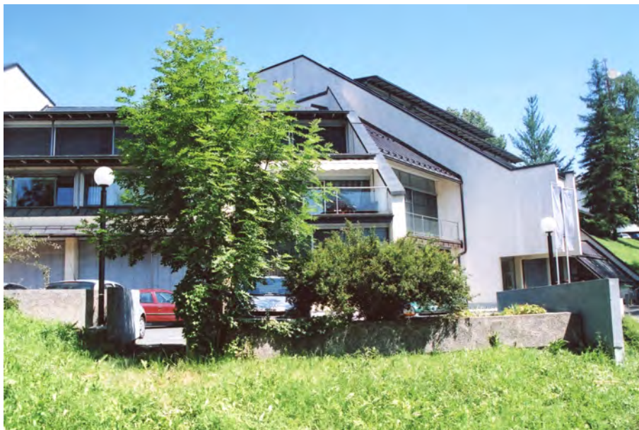
Jugovzhodni del stavbe pred pričetkom gradnje prizidka.
