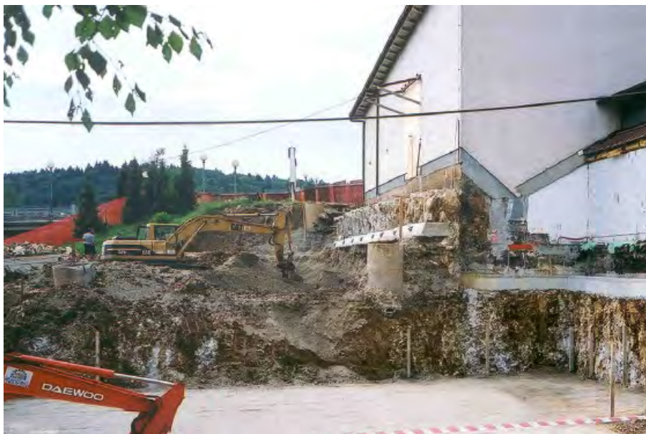
Pri gradnji prizidka je bilo treba s piloti podpreti obstoječi objekt (2002).
